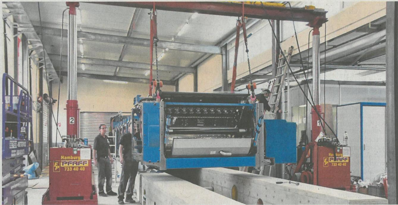
Millimetergenau werden die Elemente der neuen Druckmaschine auf den Fundamenten platziert.
